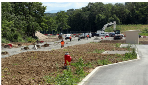
Le chantier a débuté en octobre 2019. Photo L'Alsace /Thierry GACHON
