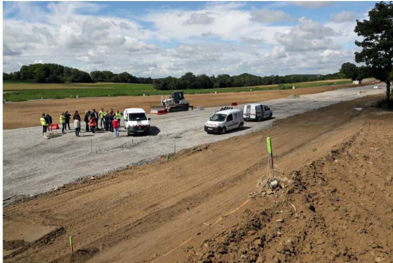
La visite officielle du chantier de la liaison entre la rue Laennec à la hauteur de Brunstatt-Didenheim et la rue de Folgensbourg, à côté de l'hôpital Émile-Muller, s'est déroulée le 18 juin. Photo L'Alsace /Thierry GACHON
